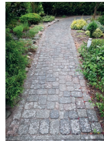
Reinigung Fußweg vorher
