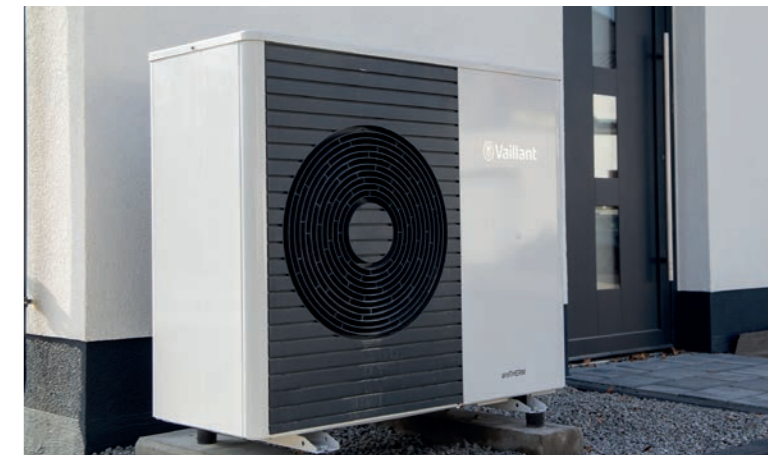
Luft- und Wasserwärmepumpe vom Hersteller Vaillant an einem Wohnhaus
