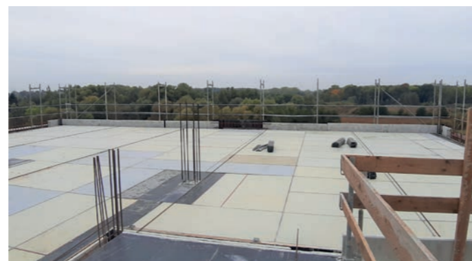
Vorbereitung der Betonage-Decke im 2. Obergeschoss Westflügel (Foto: IPC Dr. Talkenberger GmbH)
