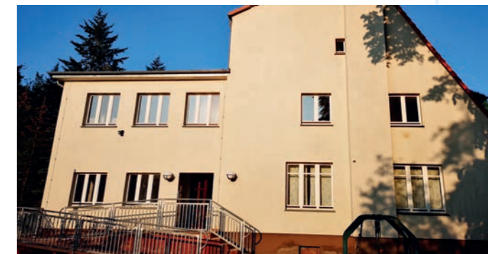
Reinigung Hausfassade nachher
