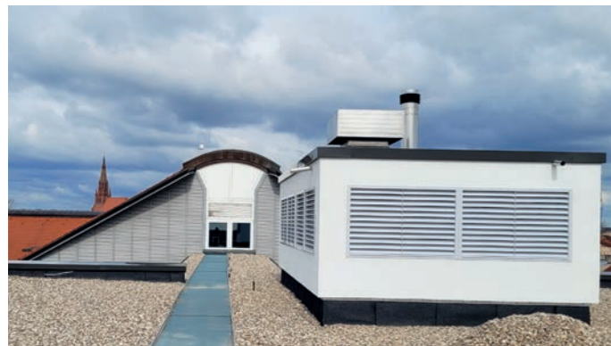
Dach mit Bettenaufzugsüberfahrt – Blick Bestandsbau (Foto: IPC Dr. Talkenberger GmbH)
