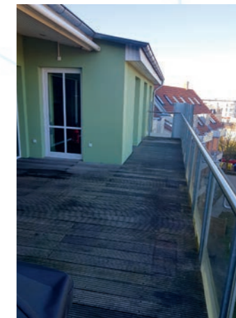
Reinigung Holzterrasse vorher
