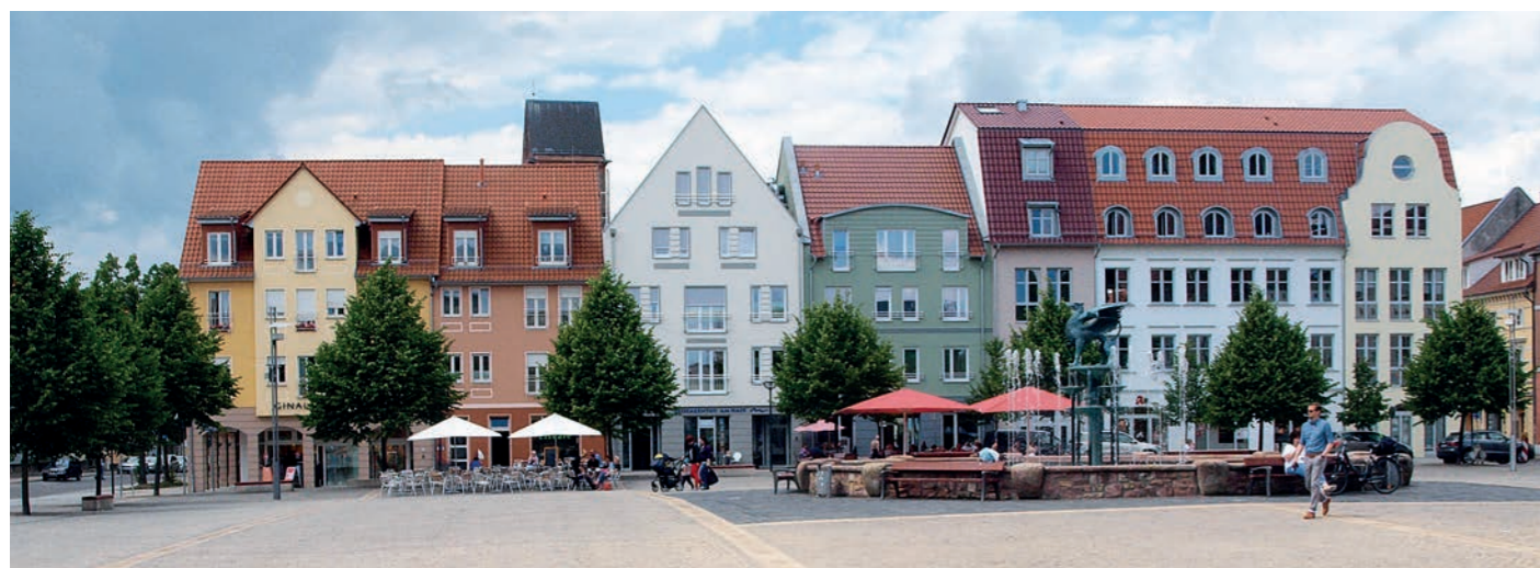
Westseite des Marktes (Foto: Grundstücks- und Wohnungswirtschafts GmbH Anklam)
