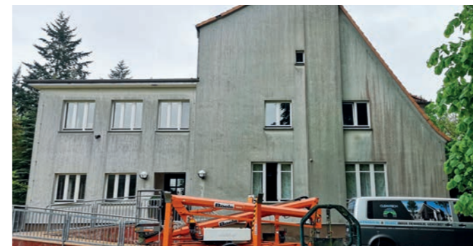
Reinigung Hausfassade vorher
